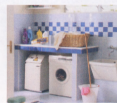
Pompa di calore installata internamente
