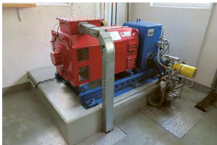
Piano superiore della centralina: la turbina per la produzione di elettricità
