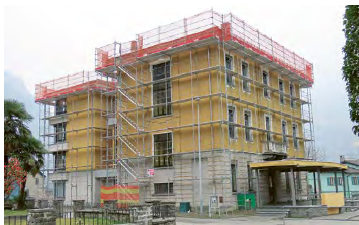
Posa dei pannelli fotovoltaici sul tetto delle scuole, primavera 2022
