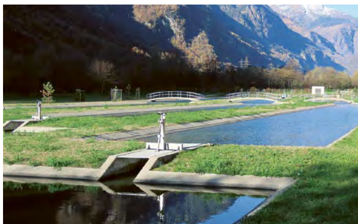
Vasche di raffreddamento dell'acqua del tunnel di base, in attesa di un uso razionale
